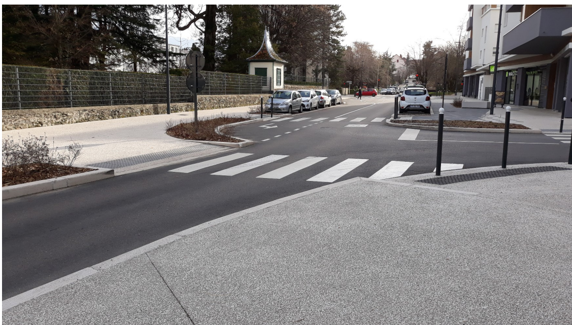
Boulevard de la République à Voiron, après les travaux
