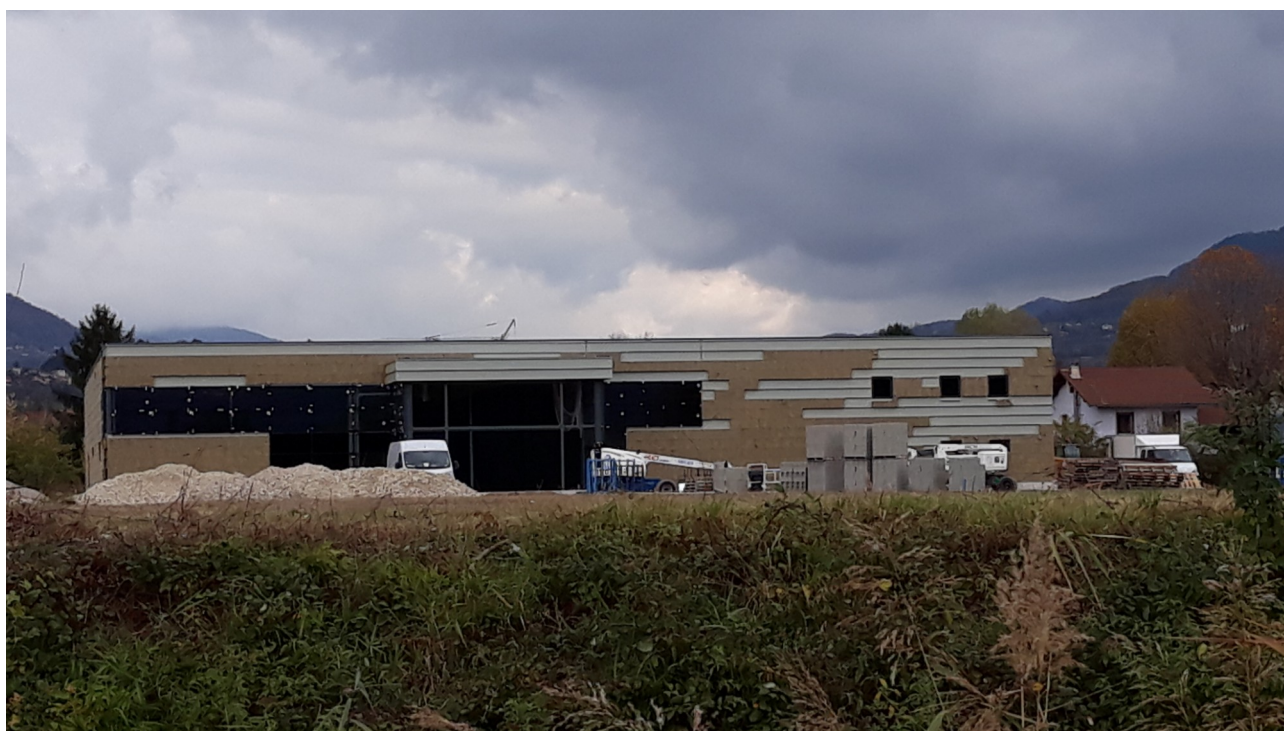
chantier de l'Intermarché - novembre 2021
