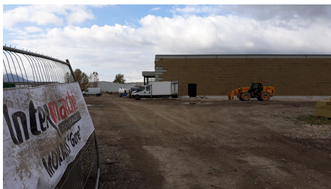
entrée du chantier de l'Intermarché - novembre 2021
