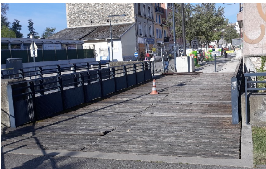
La passerelle sur la Morge avant les travaux
