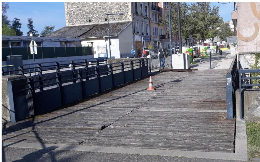
La construction de la passerelle en bois de l'avenue François Mitterrand à Voiron remonte à 2007. Les travaux avaient été menés par la CAPV. Depuis plus d'un an, la passerelle est fermée au public pour cause de détérioration. La commune s'est enfin décidée à la réparer. Ou plutôt à remplacer les lames en bois (du chêne) par des lames en plastique.
